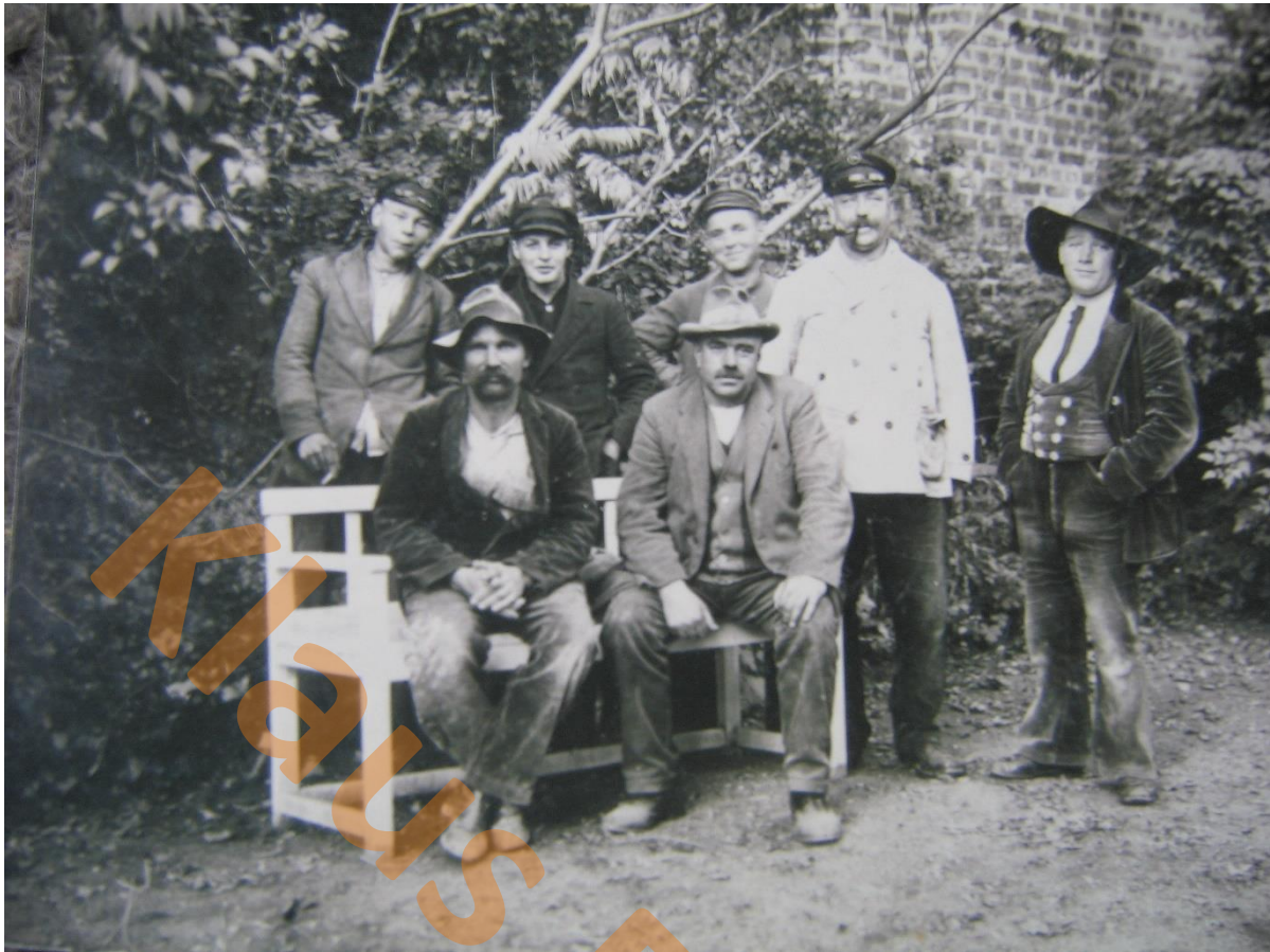
Heinrich, vorne links, als Dachdeckerhilfe
