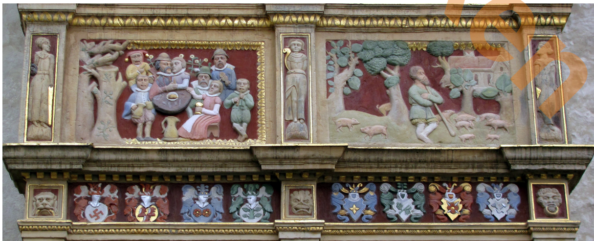
Erker des Tempelhauses mit Details, 2013
